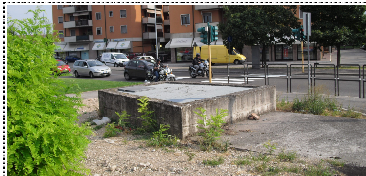
Fig. 4_ Manufatto di ispezione delle acque provenienti dal canale ramo di sinistra.
