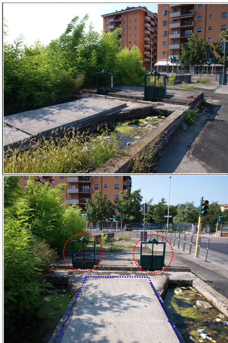
Fig. 2-3_ Manufatto di regolazione delle portate provenienti dal canale 140 G. Nella foto in basso sono evidenziate le paratoie di regolazione e la copertura delle due canalette in calcestruzzo.
